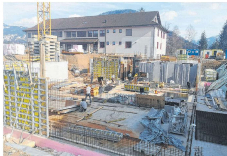
Bis zur Fertigstellung der neuen Schule bleibt die Mittelschule im derzeitigen Bestandsgebäude.
